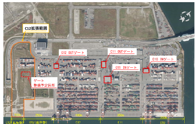
図-8 夢洲コンテナターミナル
