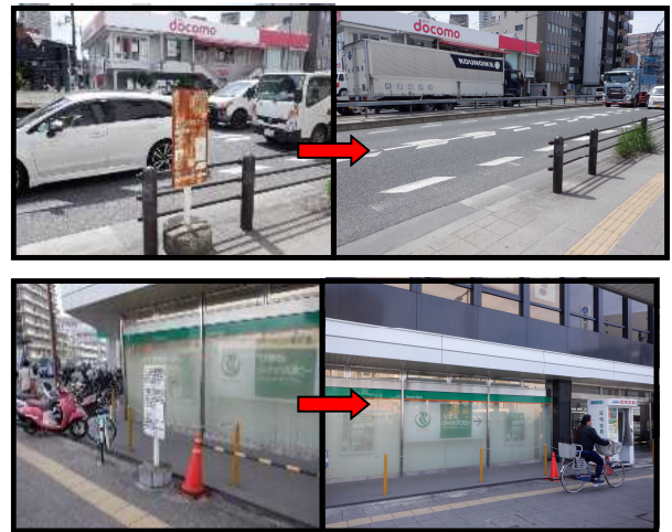
図-6 撤去前と撤去完了後の写真
