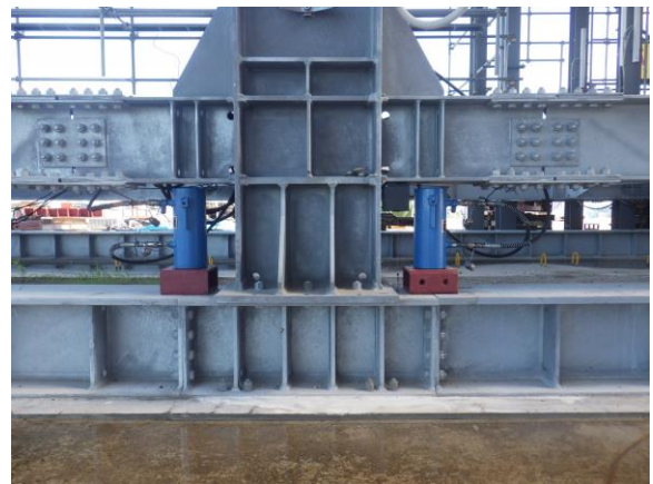
図-9 ジャッキアップ状況写真
