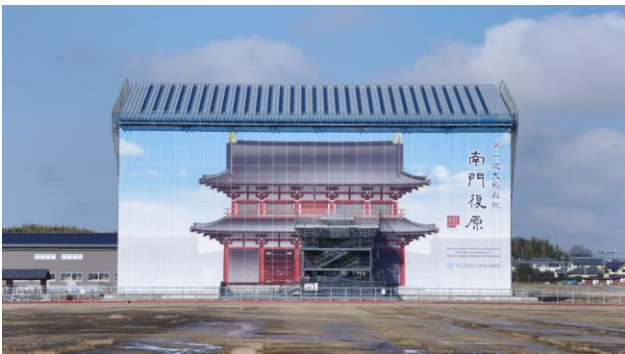
図-5 復原中の大極門 素屋根 外観写真
