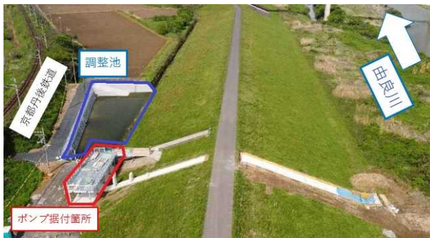
写真-4 現場実証試験箇所
