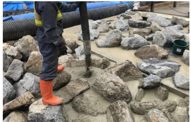
写真5 高流動コンクリート打設の様子
