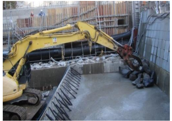
写真4 粗石敷設の様子
