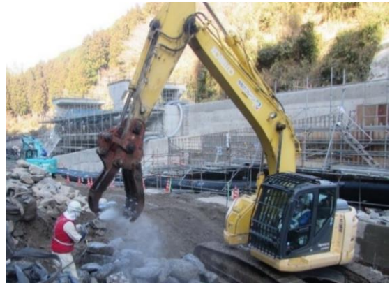
写真3 粗石洗浄の様子
