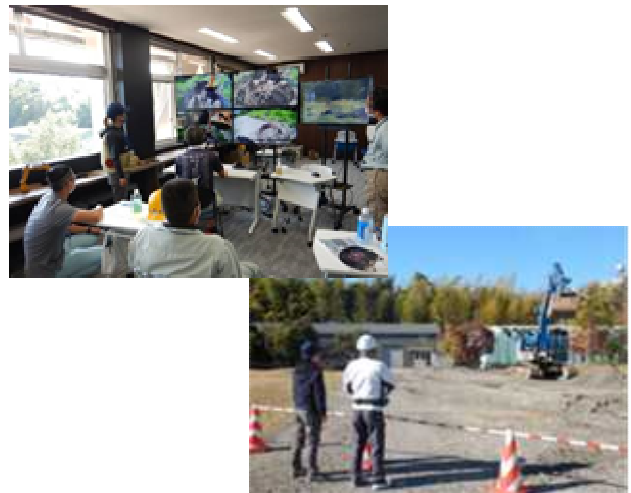
図-4 無人化施工研修
