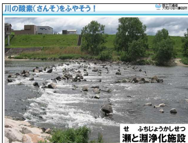
図9 瀬と淵浄化施設
