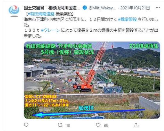
図-4 橋梁架設状況
