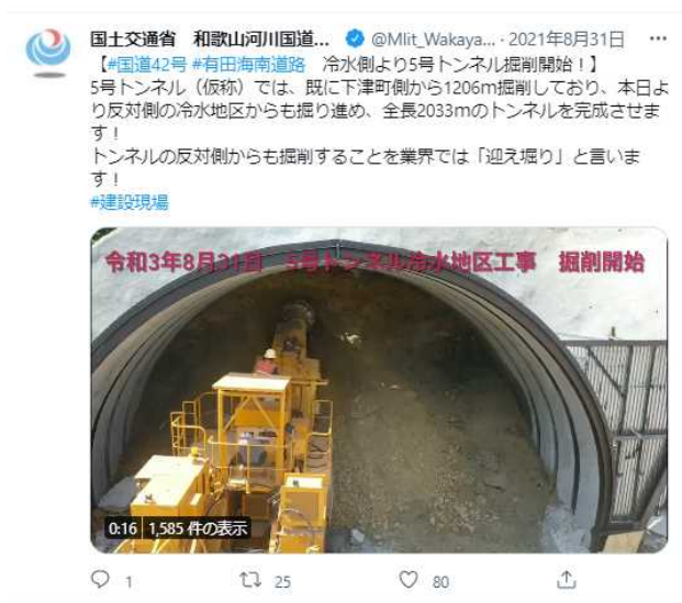
図-3 トンネル掘削状況
