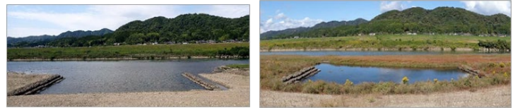
図-9 ワンド施工直後(左:2021年5月31日撮影)と経過後(右:2022年10月26日撮影)の比較
