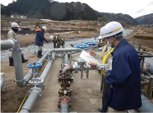
写真-3 散水融雪設備点検時の様子
