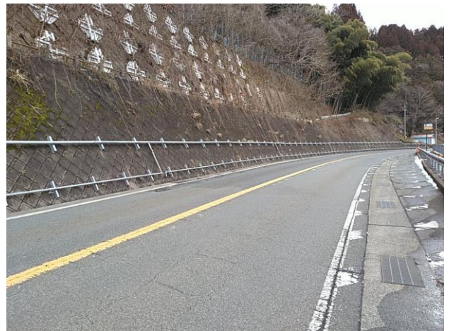
写真-1 散水融雪設備設置状況
