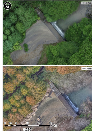
図3 砂防施設点検時オルソ画像の比較
