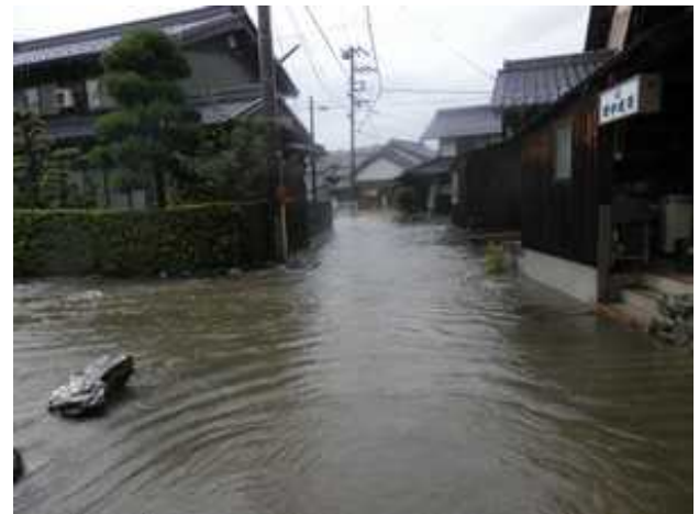
写真-4 長岡での浸水状況(米原市長岡 H24.9月)
