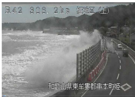
写真-2 越波事象発生状況
