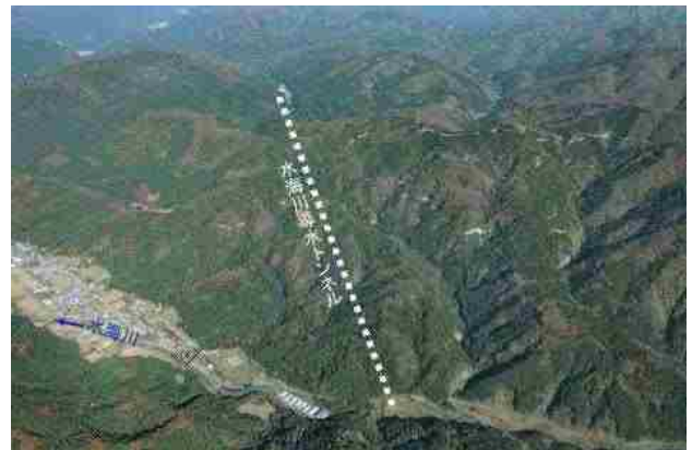
写真-1 水海川導水トンネル全景
