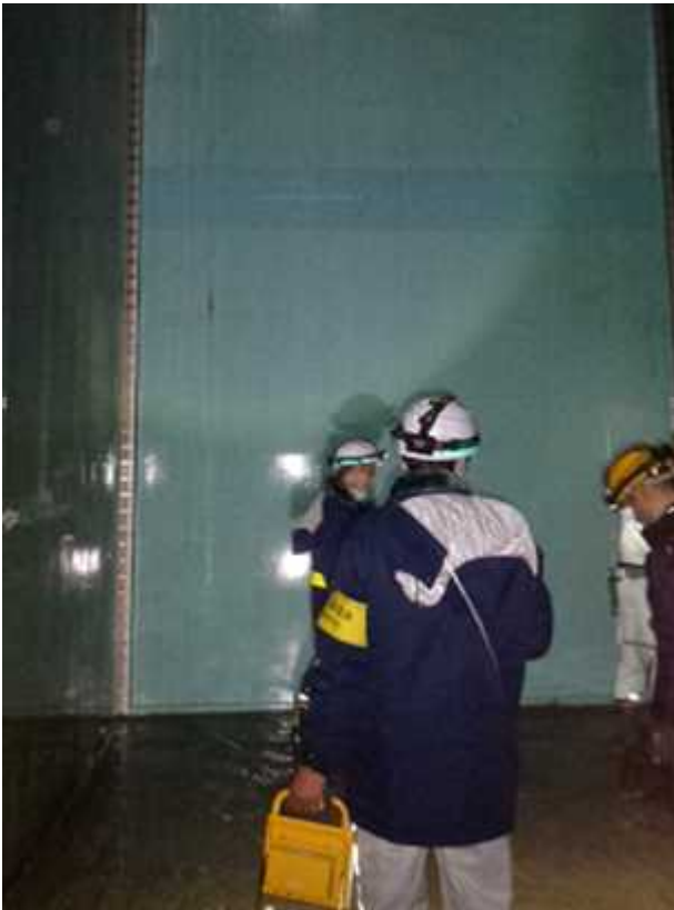
図-6 副ゲートの水密性確認状況
