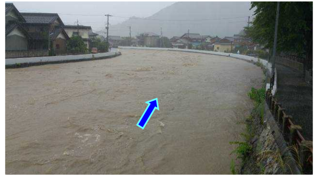
写真-3 長岡での出水状況(米原市長岡 H24.9月)
