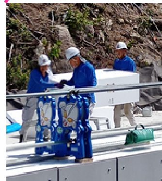
写真-5 擁壁施工及び軽量盛土材運搬状況
