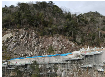
写真 - 2 下流区間の施工箇所
