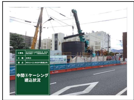
写真-6 発進立坑
