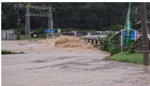
写真-1 2013年台風18号洪水 中村氏撮影（大津市中野, 荒戸橋）
