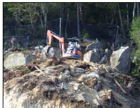
写真 - 3 転石を小割して撤去する状況
