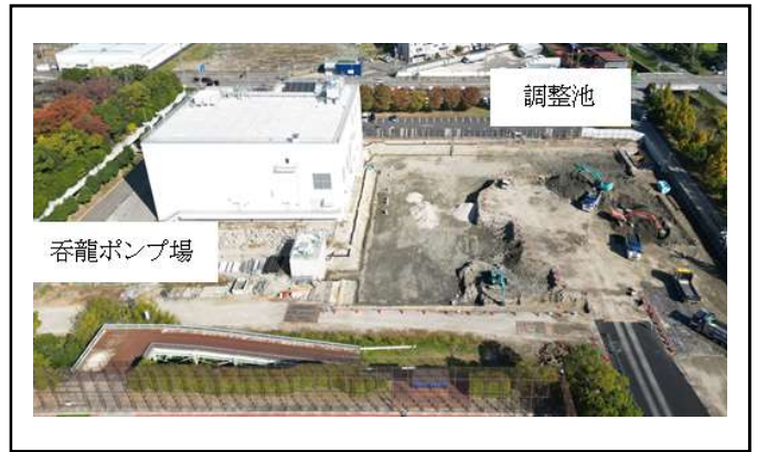
写真-5 調整池掘削状況
