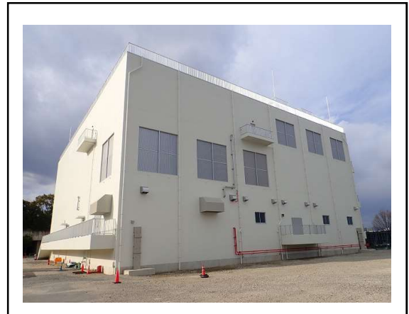
写真-9 呑龍ポンプ場
