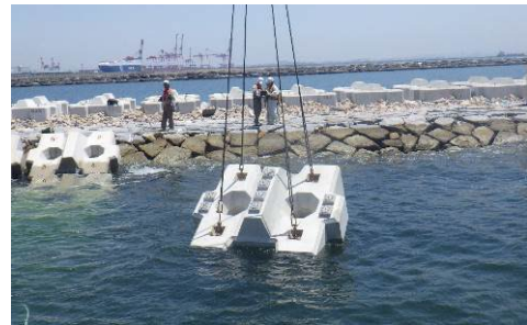
図-13 被覆ブロック据付状況
