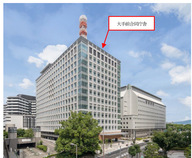
写真-1 大手前合同庁舎全景
