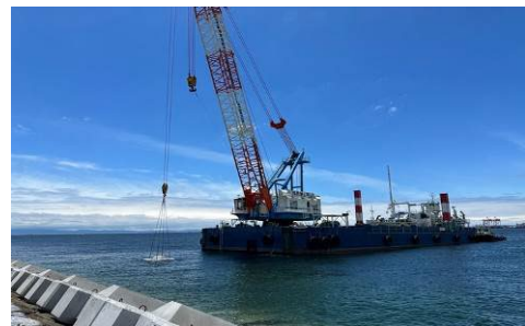
図-14 起重機船での据付状況
