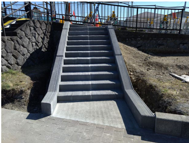
図4 3Dプリンターで作られた階段
