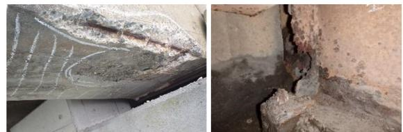
図-2 伸縮装置からの漏水による主桁端部の損傷事例
