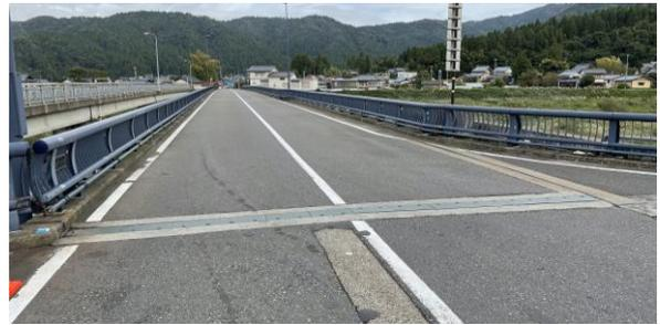
図-7 試作した伸縮装置の設置事例
