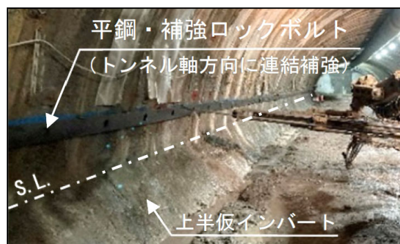
写真-4 掘削時における沈下抑制対策
