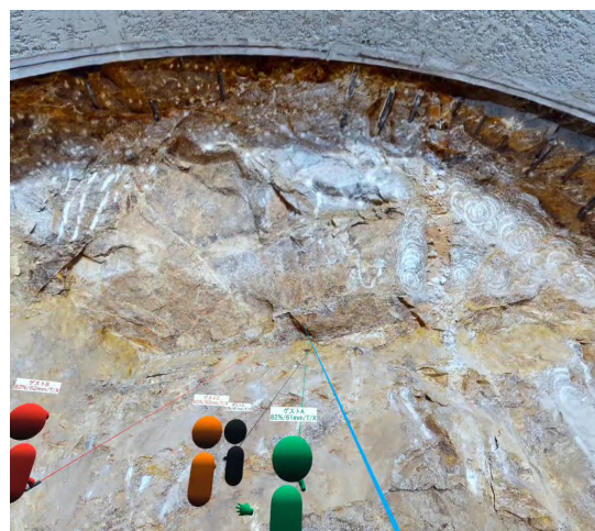
図-7 VRデータ構築したトンネル切羽周辺のVR空間
