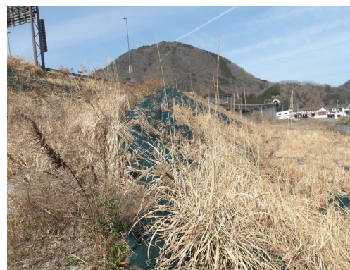
写真-4 和田山 JCT ネット全体 3月
