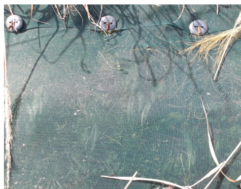
写真-3 和田山 JCT ネット表面 3月
