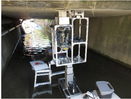
図-4 「江良2号橋」における計測状況
