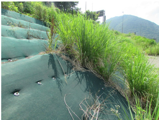
写真-8 和田山JCT ネット全体 6月
