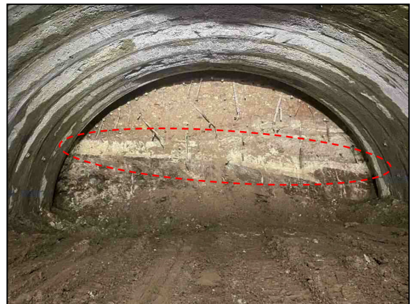
写真-1 佐野トンネルで確認された白色凝灰岩
