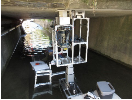
図-4 「江良2号橋」における計測状況
