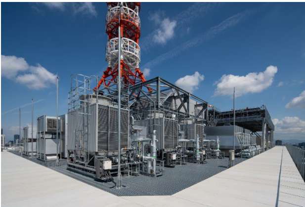
写真-2 塔屋1階設備機器置場
