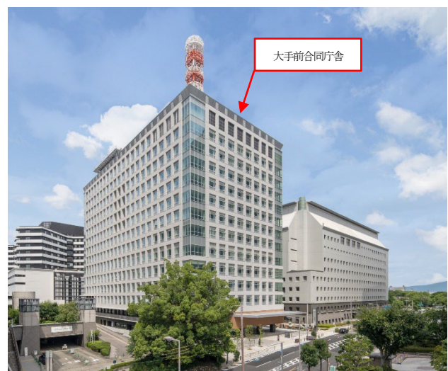
写真-1 大手前合同庁舎全景
