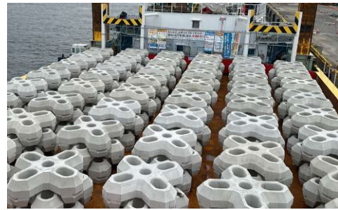
図-12 被覆ブロックを製作場所から運搬
