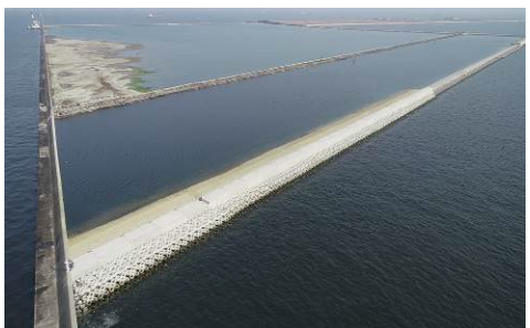
図-15 被覆ブロック据付後
