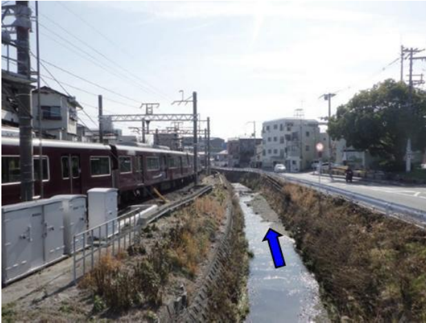
図-2 工事着手前の上の川
