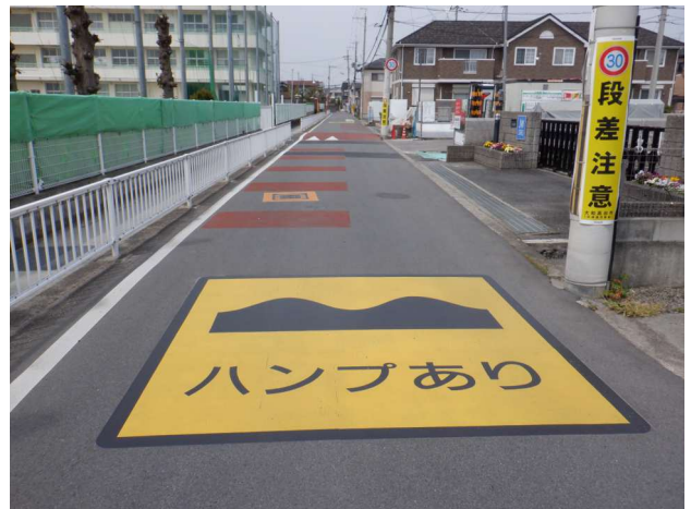
写真7 ハンプ完成の遠景
