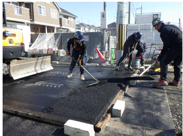
写真-2 平坦部の施工
