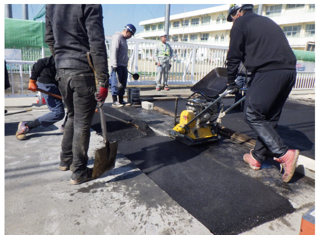
写真-3 傾斜部の施工
