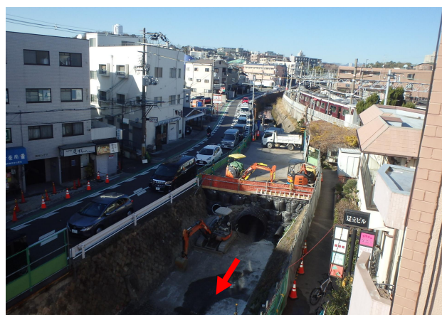
図-19 仮設ヤード整備時
