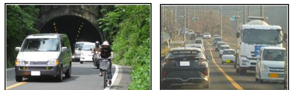
写真-1 既設トンネル及び付近の状況
