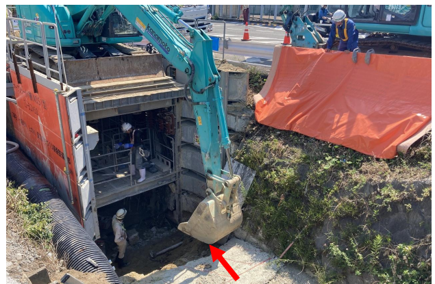
図-14 掘削作業
