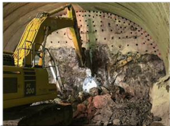
【ボアホール窄孔併用大型ブレイカー掘削】
