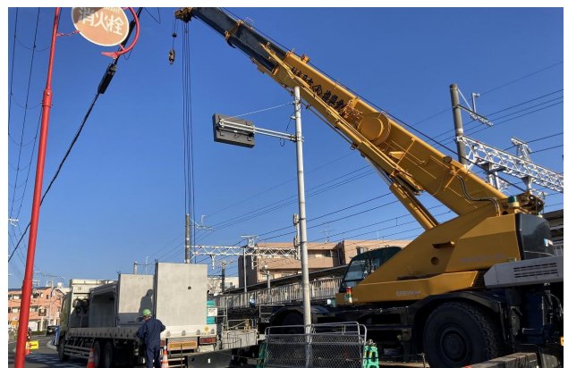
図-15 ボックスカルバート横取り
