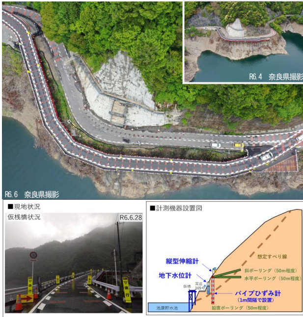
図-3 仮橋による片側交互通行の状況と計測器
