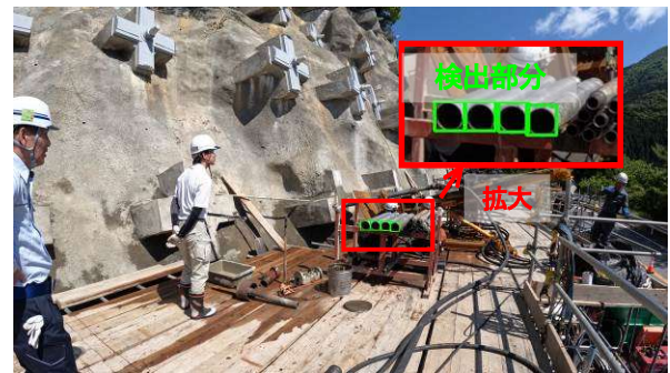
図-9 画像認識AIによるケーシング検出結果の一例
