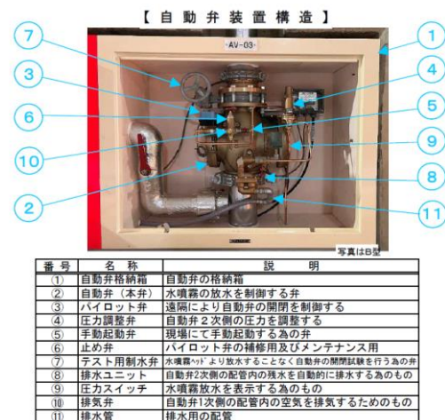
図－4 自動弁装置構造
