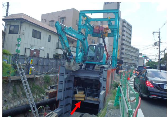
図-13 発進部 (オープンシールド機据付)
