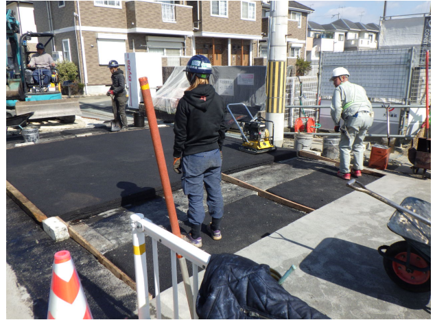
写真6 施工時の工夫 中心部に型枠設置
