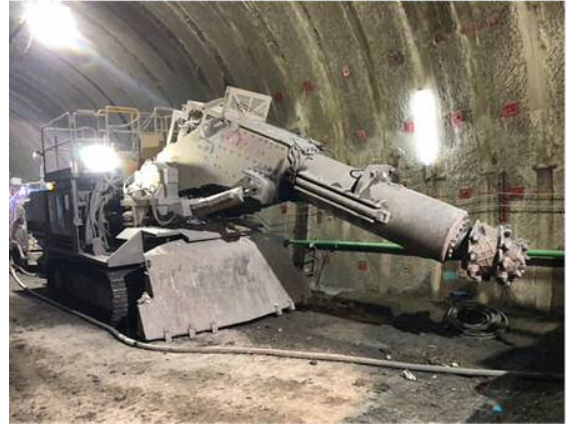
図8 自由断面掘削機(240KW級)
