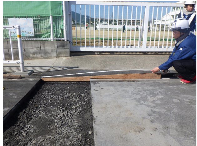
写真-1 形状を示す型枠と溝切り
