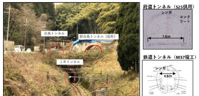
写真-2 新トンネルと既設トンネルの近接状況
