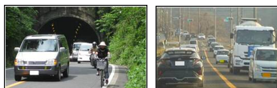
写真-1 既設トンネル及び付近の状況
