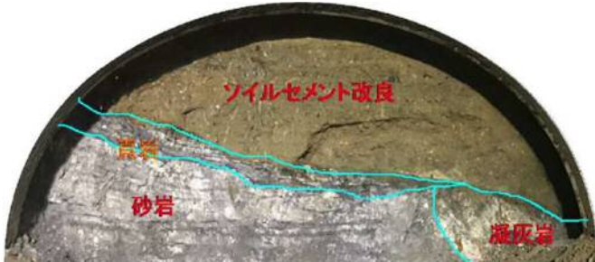
図5 低土被り部切羽状況
