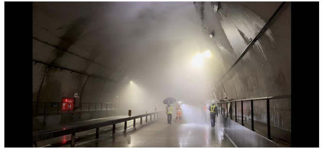
図ー7 実噴霧点検の様子
