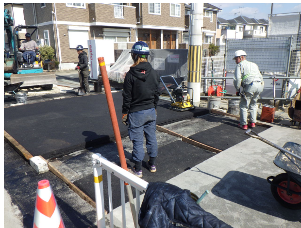
写真6 施工時の工夫 中心部に型枠設置
