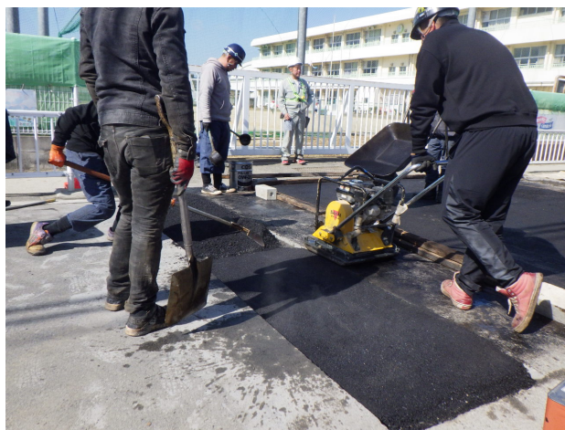
写真-3 傾斜部の施工
