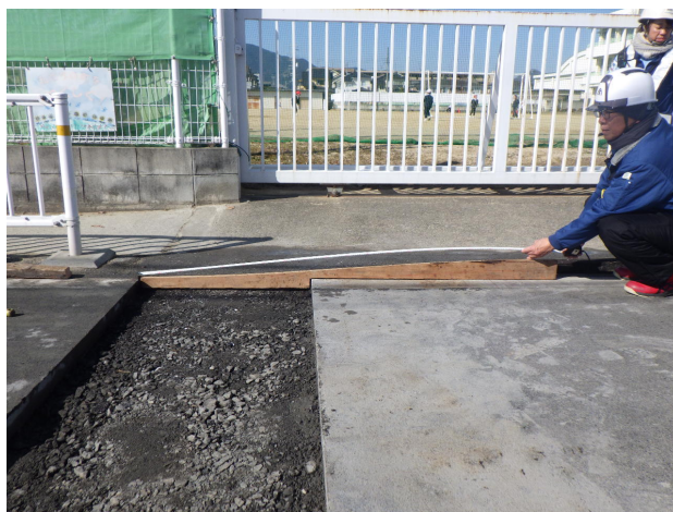
写真-1 形状を示す型枠と溝切り
