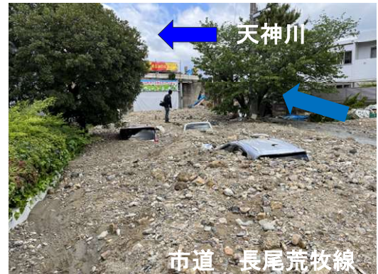
写真-3 被災状況
