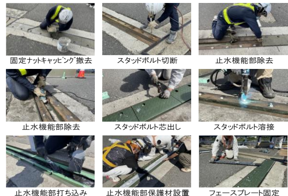
図-17 試作品設置橋梁での補修業務実施状況
