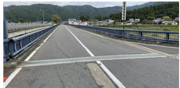
図-7 試作した伸縮装置の設置事例
