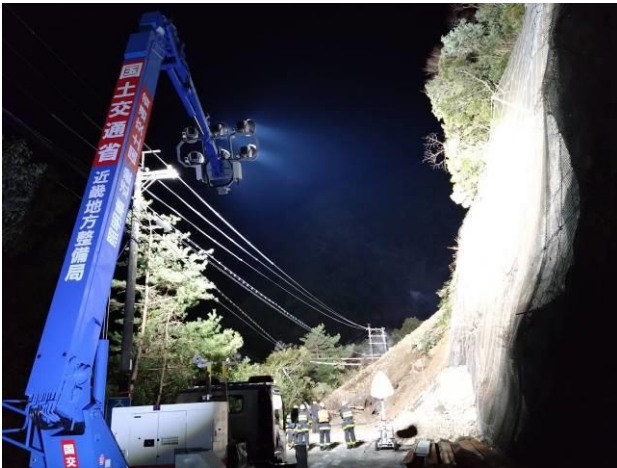
写真-5 照明車を用いた夜間法面監視の様子
