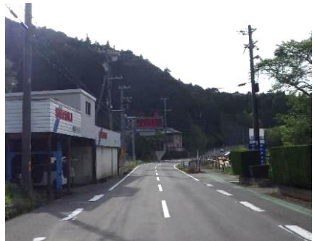
写真-4 三重県での通行止め案内(熊野市小阪地内)
