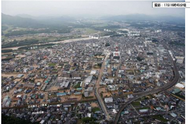
図-3 2014年8月豪雨被災状況
