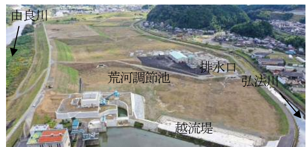
図-6 荒河調節池 航空写真
