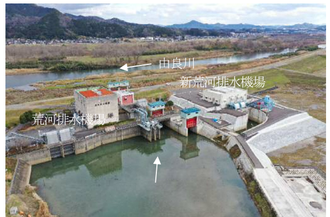
図-5 新荒河排水機場 航空写真
