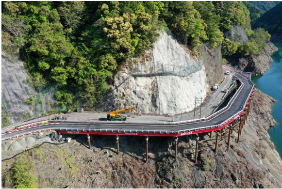
図-3 仮橋工事完了（2024年4月28日撮影）
