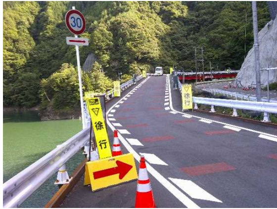
図-5 速度抑制対策（減速区画線，段差舗装）
