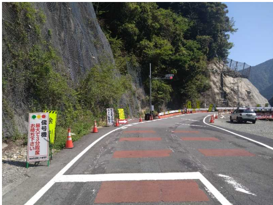
図-8 交通信号機による片側交互通行へ切替
