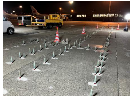
図-10 樹脂注入中の状況
