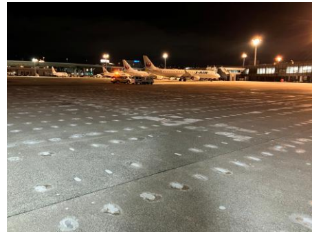
図-11 工事完了後の状況
