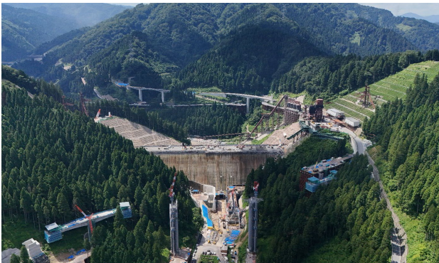
写真-1 堤体打設状況（2025年7月）
