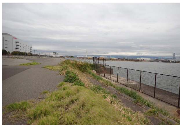
写真-7 自然植生の状況
