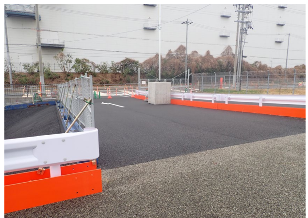
写真-10 臨港道路との擦り付け状況
