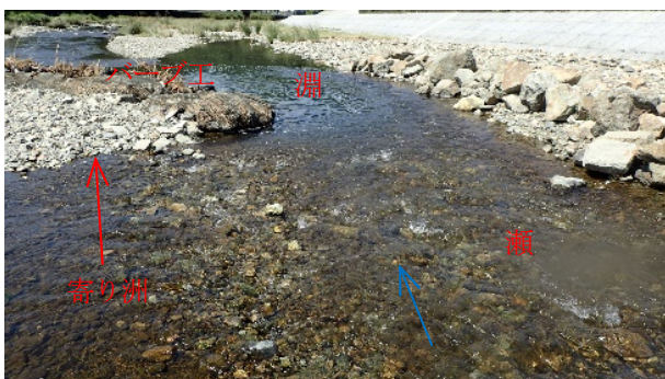
写真-4 バープ工設置後の状況
