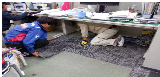
図ー4 カーペット張りの作業風景
