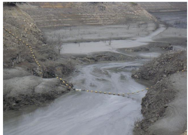
写真-2 永源寺ダム貯水池内堆砂状況
