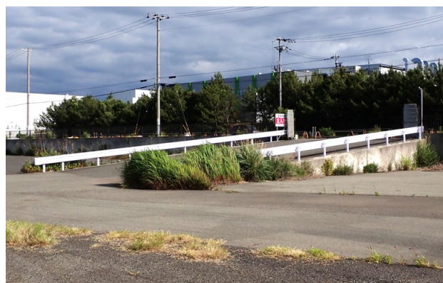
写真-8 自然植生の状況
