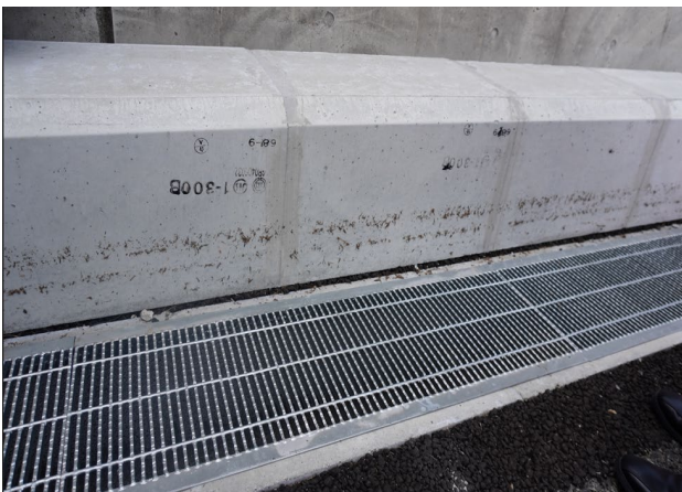
写真-12 側溝の設置
