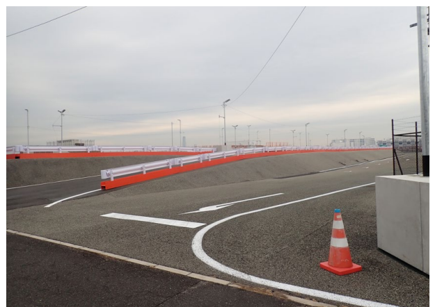
写真-11 急勾配を有する傾斜の改修状況
