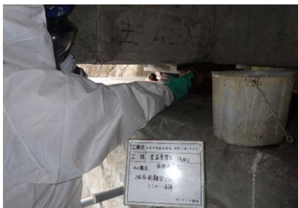
写真-2 塗装塗り替え状況（剥離剤塗布）
