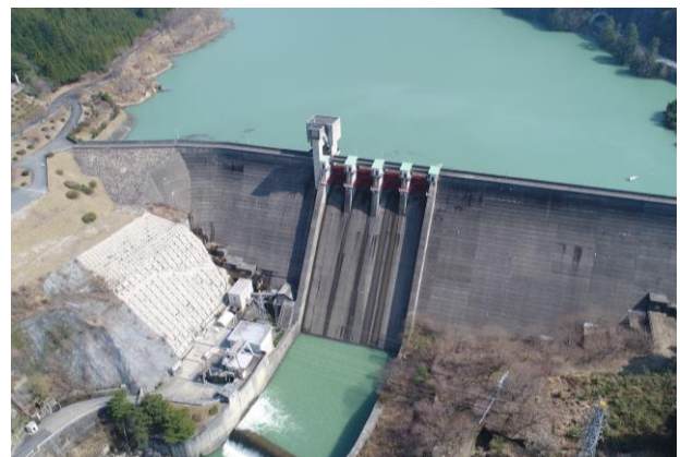
写真-1 永源寺ダム全景
