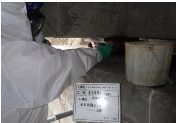
写真-2 塗装塗り替え状況（剥離剤塗布）
