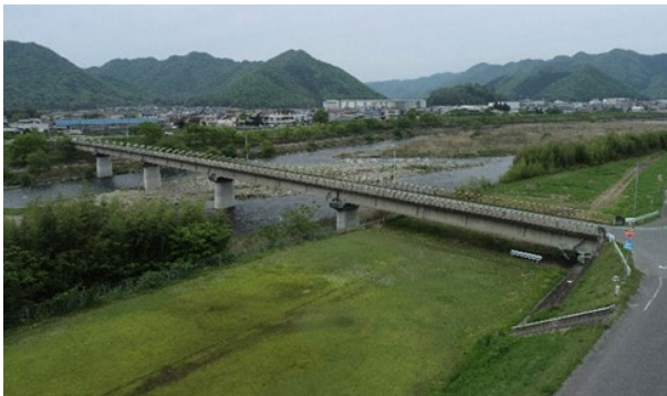
写真-1 兵庫県道437号 林田新宮線 曽我井橋
