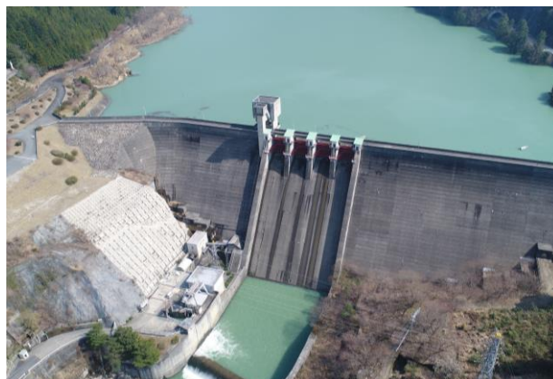
写真-1 永源寺ダム全景
