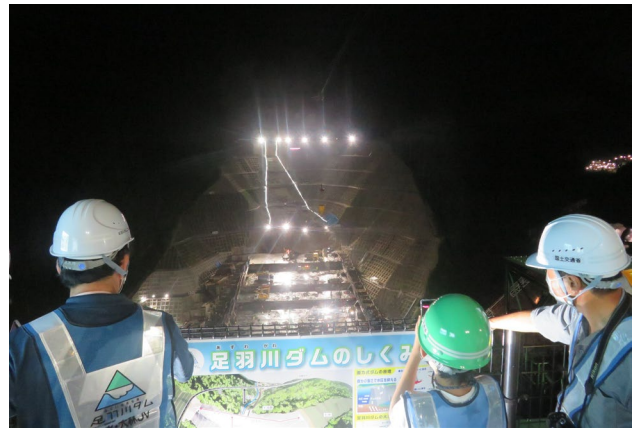
写真-2 ダムライトアップされた工事現場の見学
