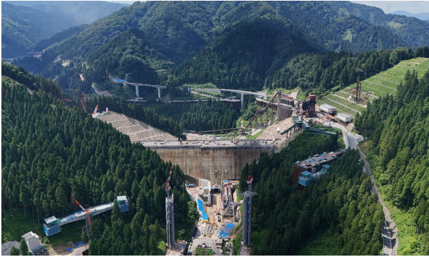
写真-1 堤体打設状況（2025年7月）
