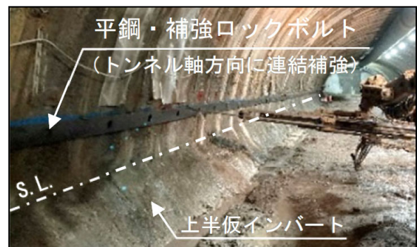
写真-4 掘削時における沈下抑制対策
