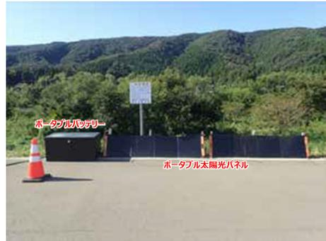
図-5 西下野地区に設置したポータブルバッテリーとポータブル太陽光パネルの様子
