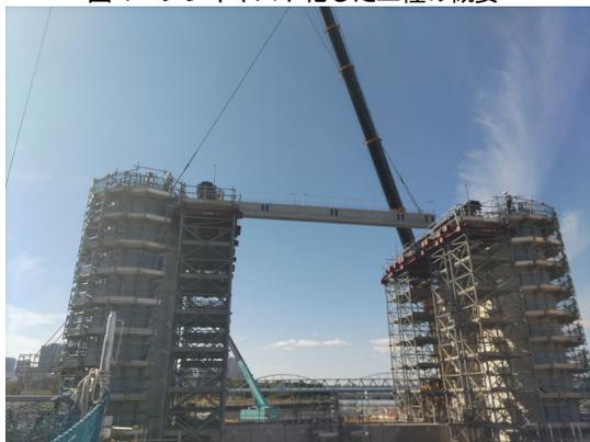
図-8 プレキャスト操作台 (PC桁) の架設状況
