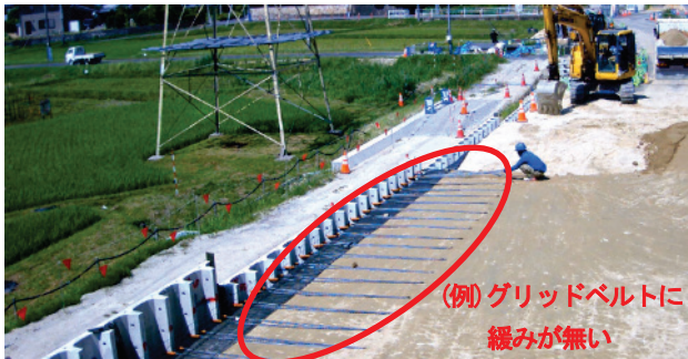
図-5 補強材の設置・敷設におけるタイムラプスでのチェック(施工範囲全体)
