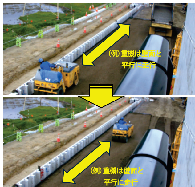
図-4 敷均し・締固めにおけるタイムラプスでのチェック
