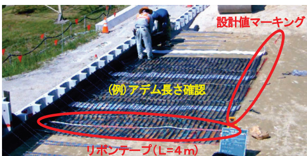
図-7 補強材の設置・敷設におけるタイムラプスでの寸法確認
