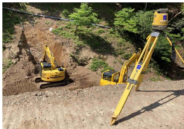
写真-3 杭ナビショベル
