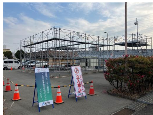
写真5_仮設足場設置状況
