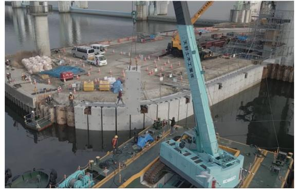
図-9 プレキャスト笠コン・被覆コンの施工状況
