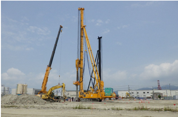
写真-4 機械攪拌の作業
