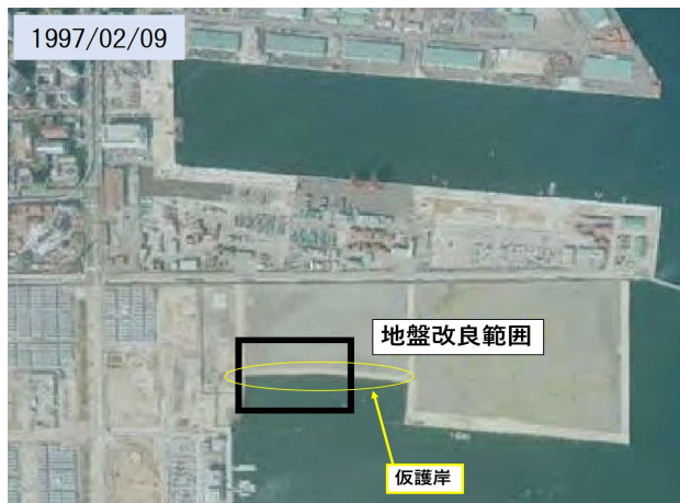
写真-5 埋め立て時の航空写真
