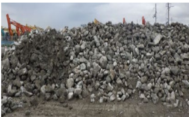
写真-5 撤去した地中障害物
