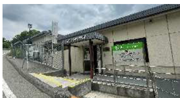
図-3 亀の瀬地すべり歴史資料室（昭和61年整備）
