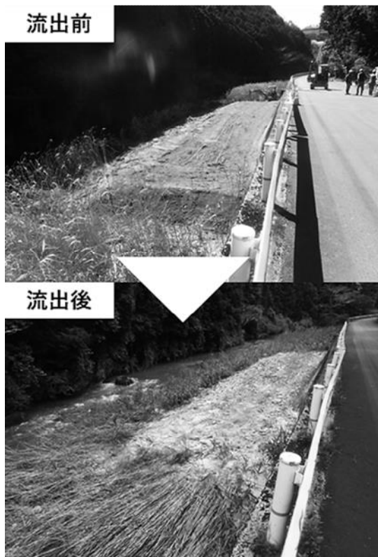
図-4 布目ダム土砂還元の実施状況
