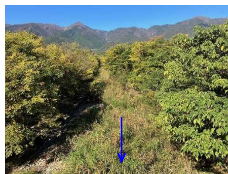
図-3.2 土砂が堆積し、植生が繁茂する比良川の河道
