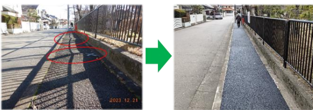
図-4 公園周辺部の歩道改修前後写真
