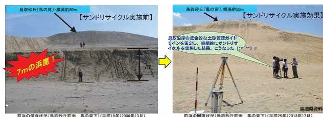
図-4.5 サンドリサイクルによって解消した浜崖
