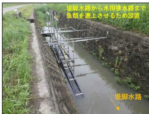
簡易魚道 設置・通水：5月11日 一時撤去(大雨)：6月2日 再設置・再通水：6月5日 撤去：6月15日
