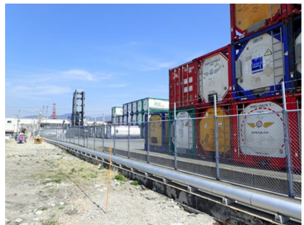
写真-7 施工範囲(2)のコンテナ存置状況
