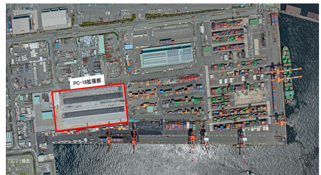
写真-8 工事完了後のPC-18拡張部
