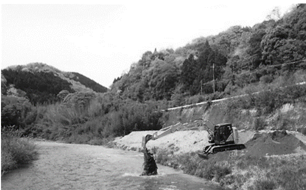
図-5 木津川本川における土砂還元の実施状況
