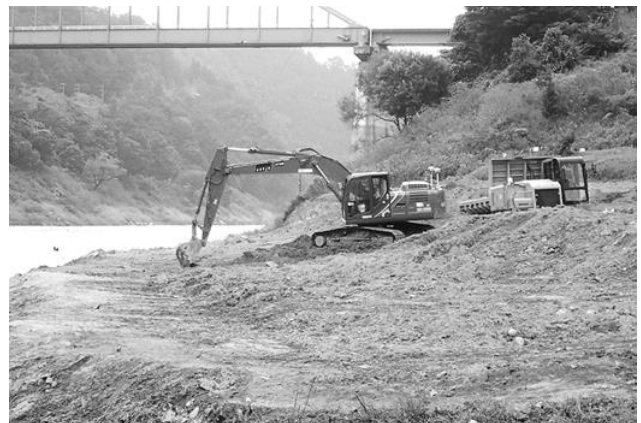
図-7 高山ダム堆砂除去工事
