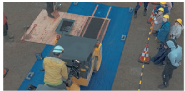
図-5 道路模型製作の様子
