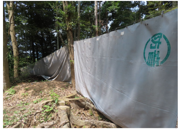
図-14 防音シート設置状況
