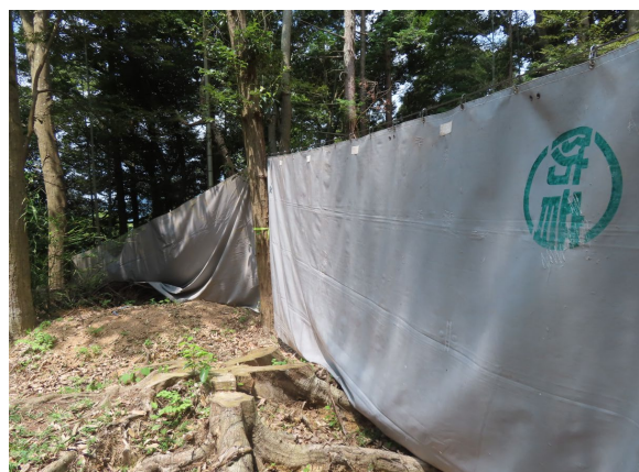
図-14 防音シート設置状況
