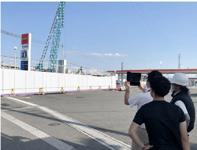
図-6 ARによる施工時現場状況の確認
