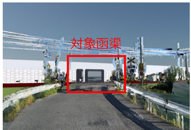
図-4 函渠の視認性確認
