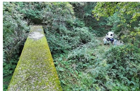
写真-3 UAV点検状況
