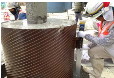
図4 高炉セメントC種充填施工（鋼管ソイルセメント杭）
