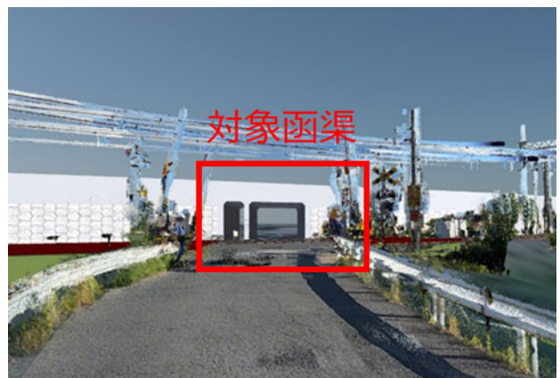
図-4 函渠の視認性確認
