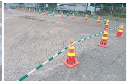
図-8 ④BTTカラーコーン設置状況
