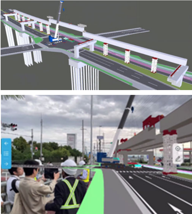
図-5 ARによる架設工法の確認
