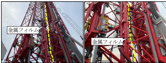
写真-5 ケーブルへの電磁波遮断対策
