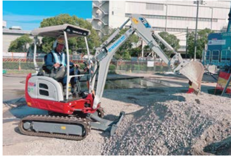
図-6 電動バックホウの稼働状況
