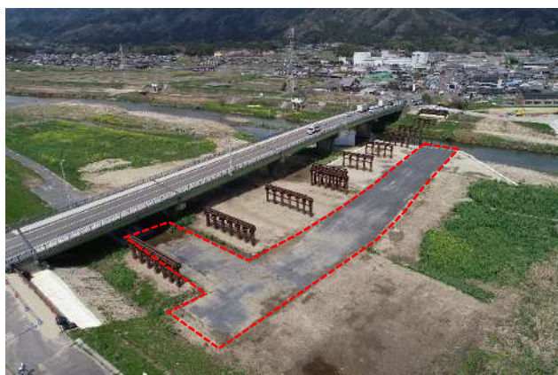
図-11 下部工完了時の施工ヤード
