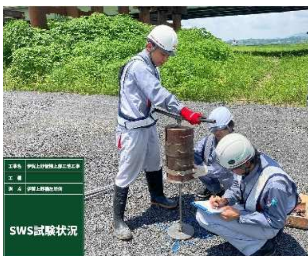
図-9 現地計測状況
