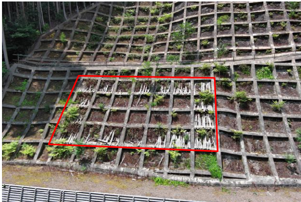
写真-4 試験区③の全景 (2026年 7月)
