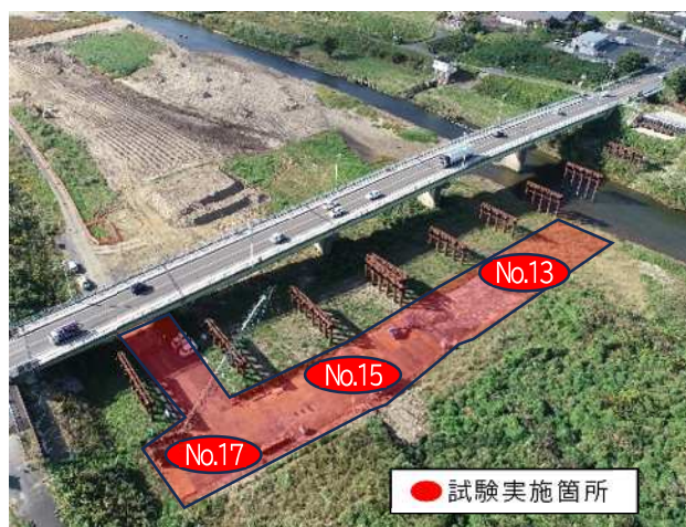
図-8 現地施工ヤード
