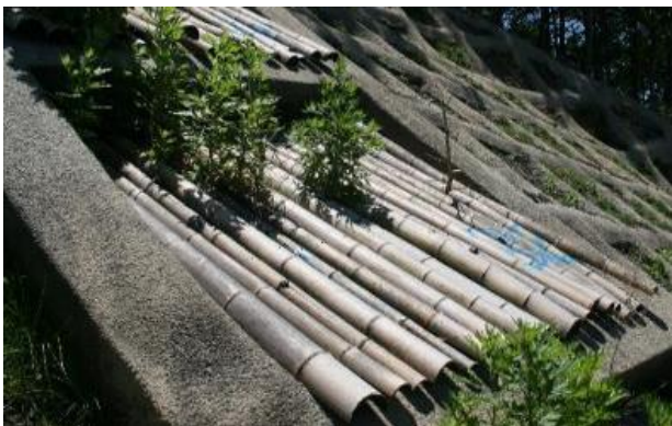
写真-1 法枠工に設置した竹被覆工
