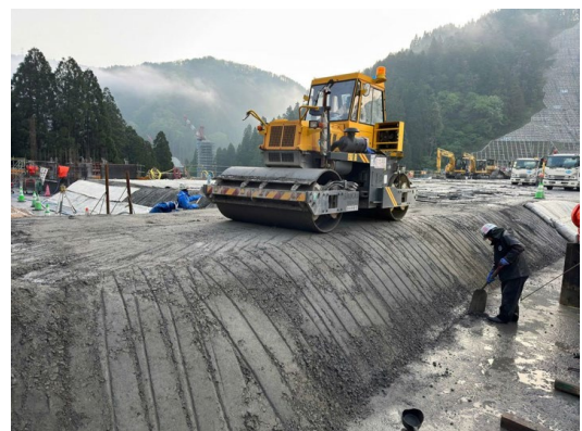
図-15 11t振動ローラによる転圧
