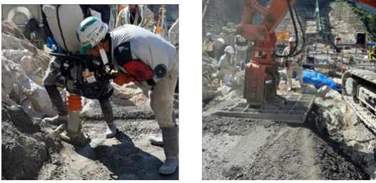
図-6 試験施工の状況
