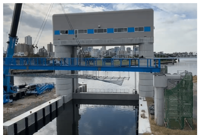
図-2 淀川大堰閘門（2025年11月時点）
