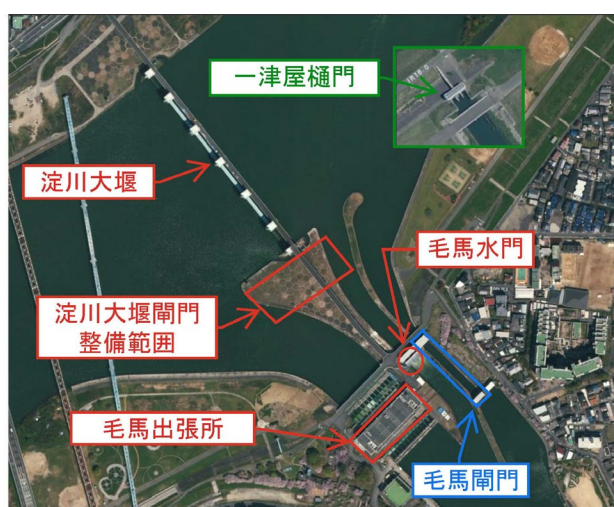
図-1 淀川大堰全体写真（大堰閘門整備前）
