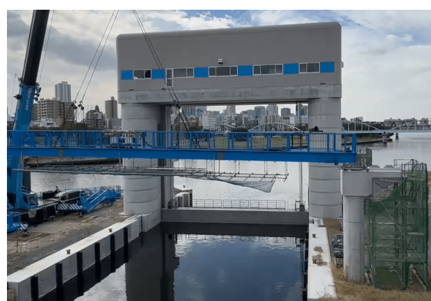
図-2 淀川大堰閘門（2025年11月時点）
