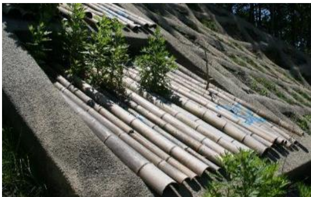
写真-1 法枠工に設置した竹被覆工
