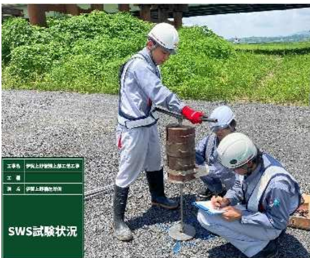
図-9 現地計測状況
