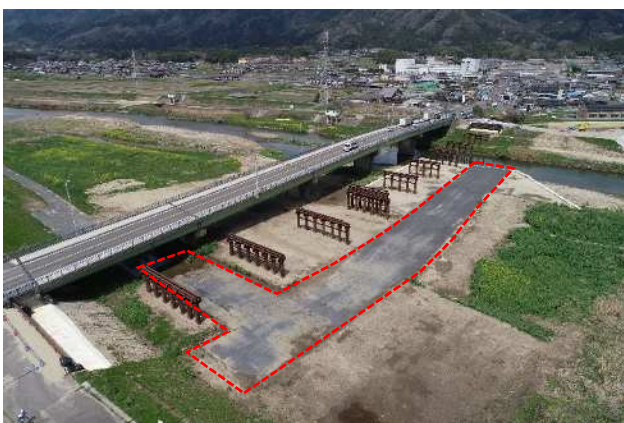
図-11 下部工完了時の施工ヤード
